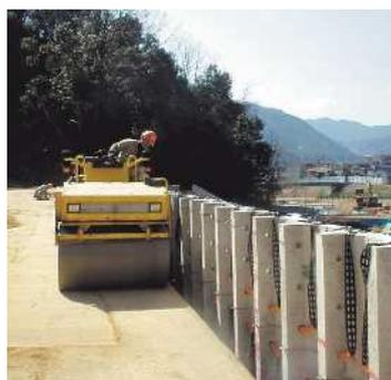
重機による壁面近傍転圧状況
