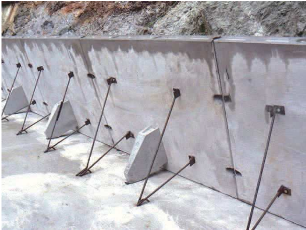
連結金具溶接完了
