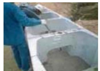
BSBブロック敷設・間詰コンクリート打設完了
