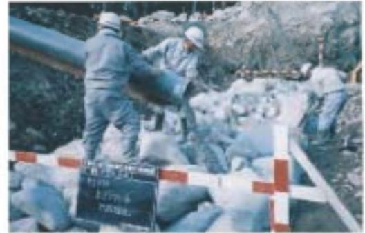
新粗石BSB工法とは、粗石コンクリート工法という既往の技術を基本にしながら、現場発生土の有効利用とコスト縮減、さらにCO<sub>2</sub>の発生の大幅な削減の観点から開発された砂防の新工法で、施工現場で発生した粗石を200mm~500mmに選別して事前に敷き詰め、敷き詰めた粗石の間に流動性の高いコンクリートを流し込み、砂防構造物を構築する工法である。
