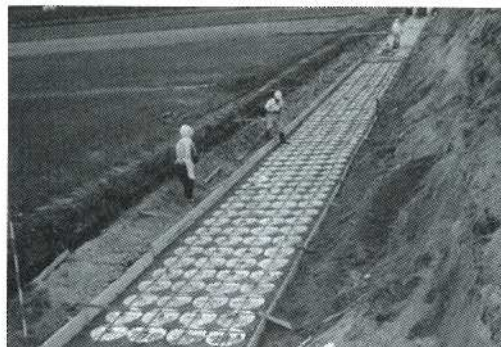
擁壁での施工事例 (マイ独楽の敷設状況)
